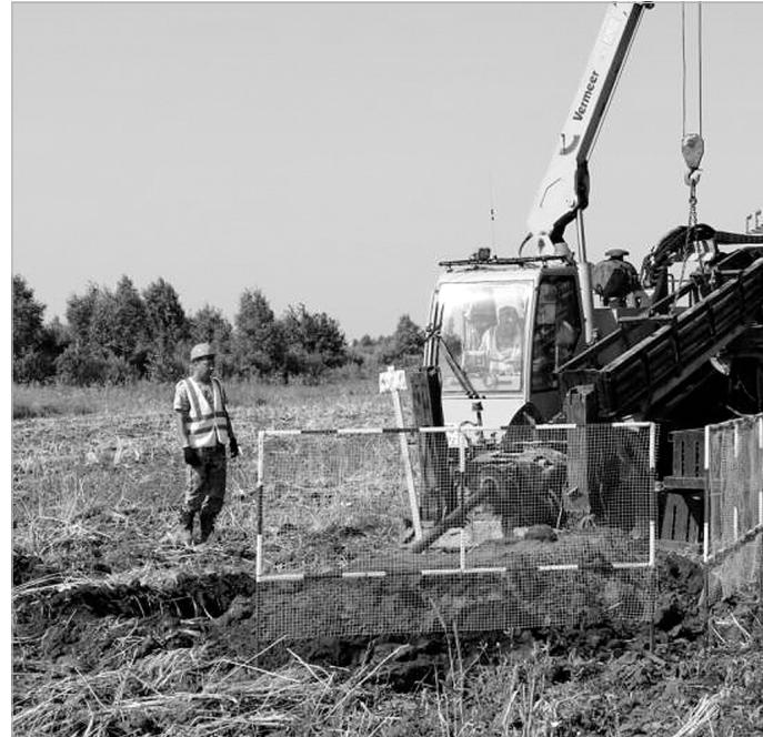
Началось строительство водоводов к селам Каскара, Ембаево, Яр и деревне Тураево. Будет проложено более 20 километров трубопроводов. Работы ведутся одновременно на трех участках.
