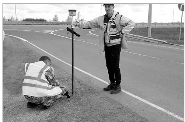
В каскаринском направлении идут работы по строительству водовода.
