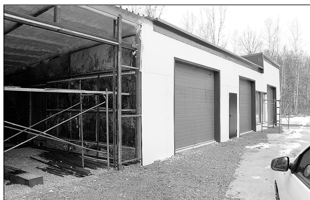
Строится станция технического обслуживания для автомобилей.
