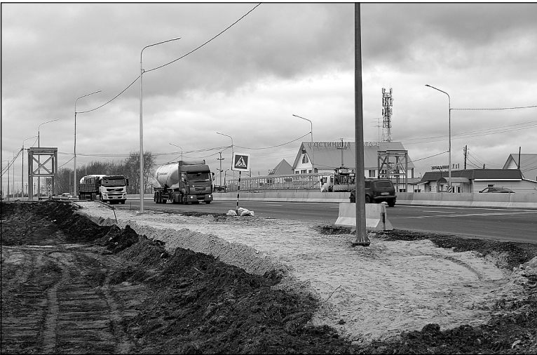
На федеральной трассе в районе Борков ремонт близится к завершению.
