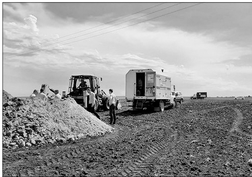
Над устранением аварии на Червишевском водоводе работают коммунальщики района и специалисты «Тюмень Водоканала».
