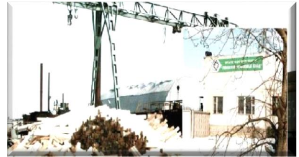
Завод по производству березового и активированного угля «Тюменский пиролизный завод»
